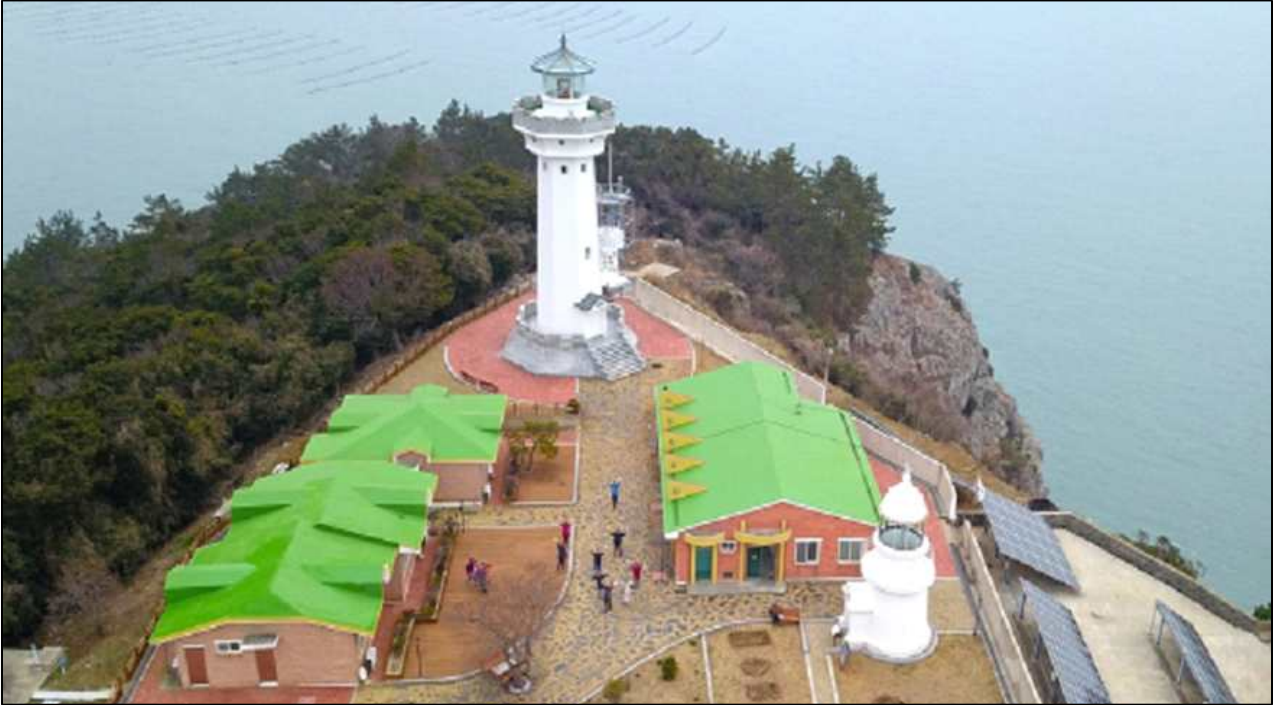
< 당사도등대 전경/ 新등대(上), 舊등대(下) >
